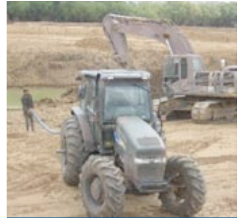
La poursuite des travaux. © Frei Gilvander Moreira
